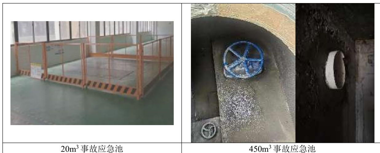
风险防范措施照片
